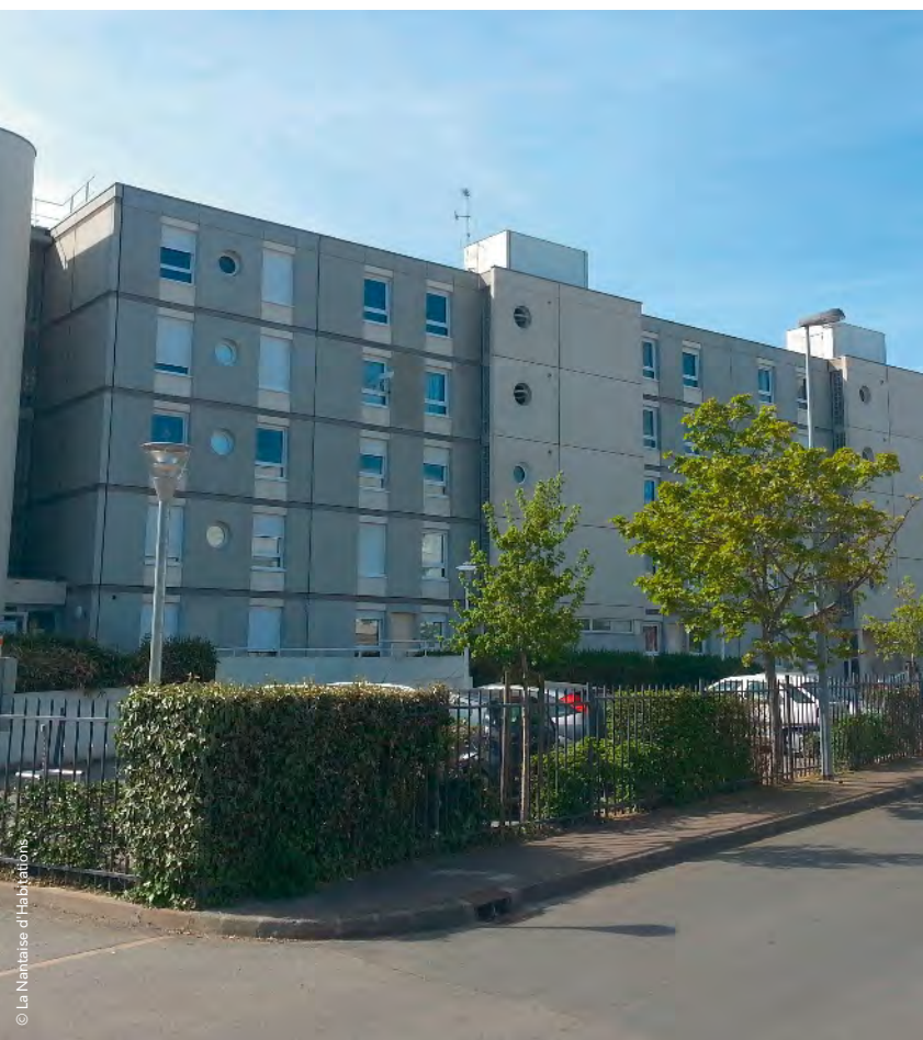
La résidence La Grande Noue fait partie des quatre résidences nantaises en cours d'étude de faisabilité pour le raccordement au réseau de chaleur urbain de Nantes Métropole.
