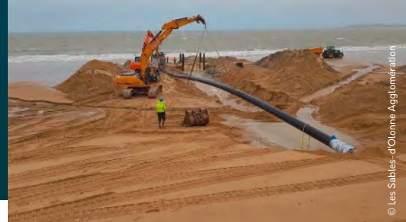
Installé depuis 1999 sous le sable de la Grande Plage des Sables-d'Olonne, le système Ecoplage permet de lutter contre l'érosion.
