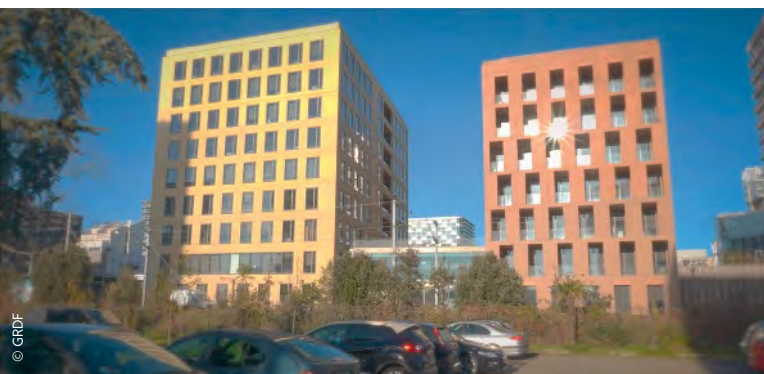
Situé dans le quartier d'Euronantes Gare, le nouveau siège social de GRDF s'étale sur 6 700 m 2 .
